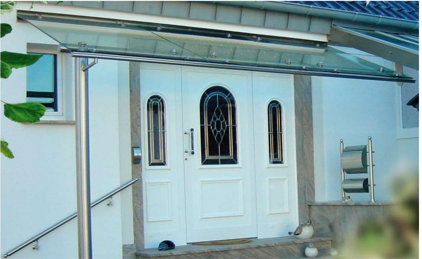
Das zur Glasauflage frontseitig angebrachte Statikrohr wird durch die linke Säule und die rechte Sparrenbefestigung gehalten (Basis: Sky II)
