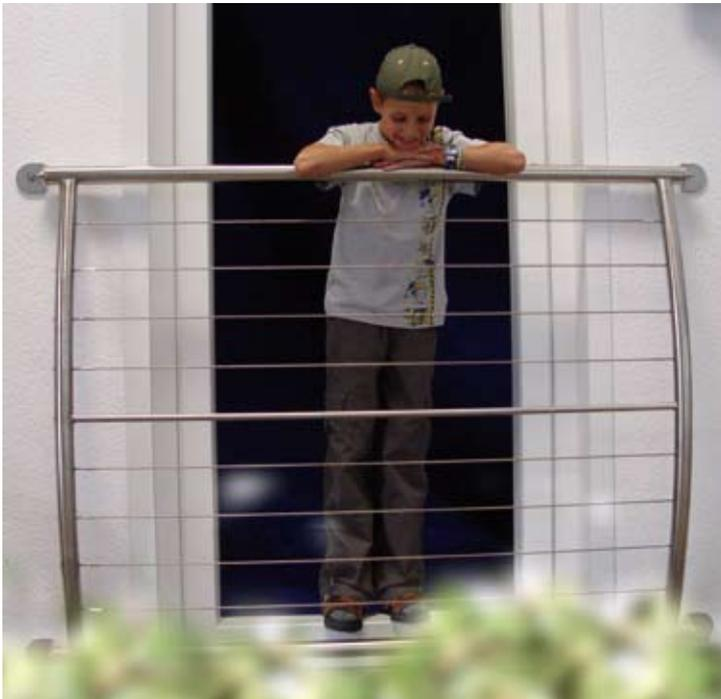
"Sinus" ist das Edelstahlgeländer mit der "dritten Dimension" (Wölbung nach außen - TRAV-konform)
