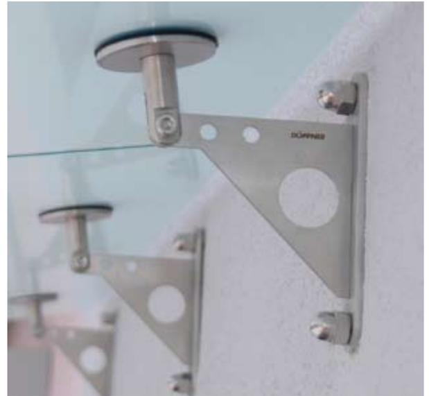
Detail der Lindo-Wandkonsole mit variablen Glaspunkthaltern
