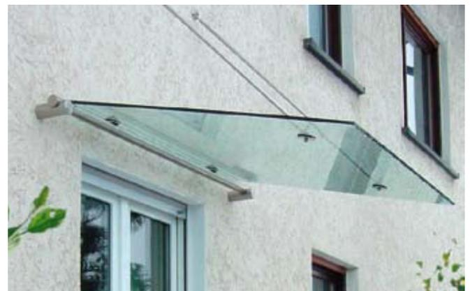
Mit Hilfe der wandseitigen Statikrohr-Konstruktion können für die Montage nicht geeignete Bereiche überbrückt werden (z.B. Rollläden, Oberlicht, ...)
