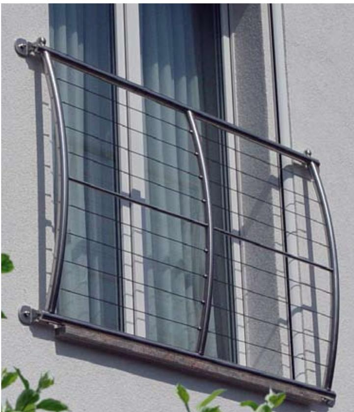
Bei größeren Breiten, z.B. bei doppelflügeligen Türen, erhält "Sinus" einen zusätzlichen Mittelbogen
