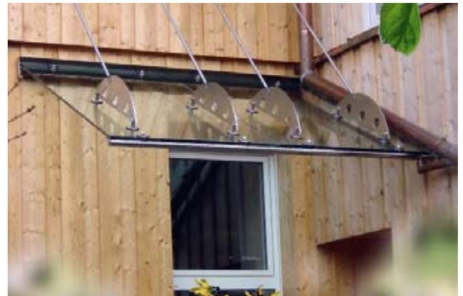
Abgehängtes Glasvordach mit oberhalb der Gläser angebrachte Bögen, ermöglicht eine Dachausladung von bis zu 2000 mm (Sky II "Rainbow")
